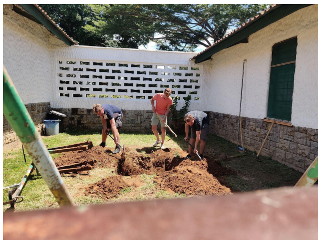
werkzaamheden voor zonneboilers (2022)
